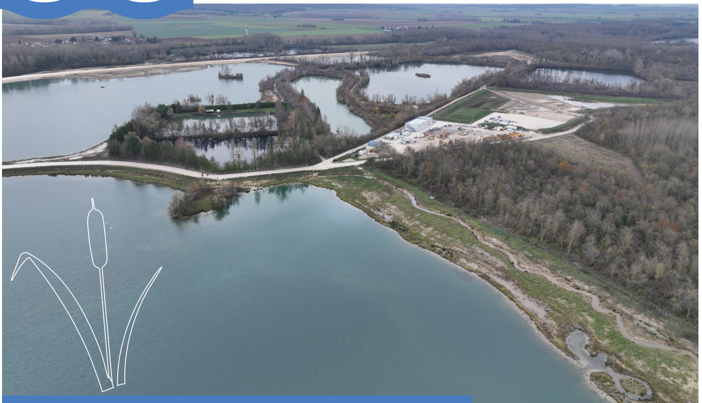
Vue de la base vie principale du chantier et des travaux réalisés sur l'aval de la noue d'Auvergne
