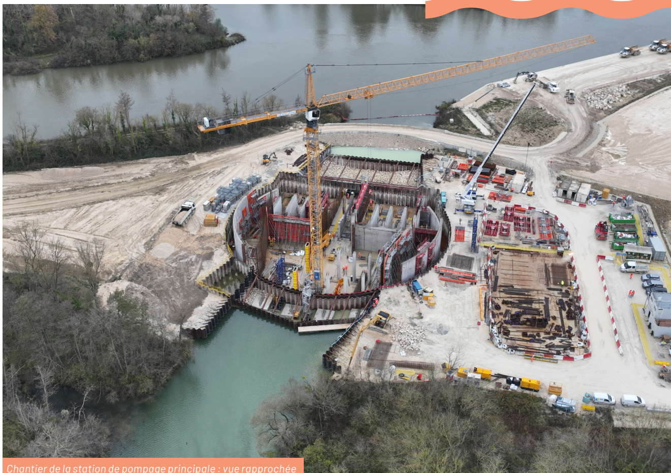
Chantier de la station de pompage principale : vue rapprochée des travaux de génie civil en cours
