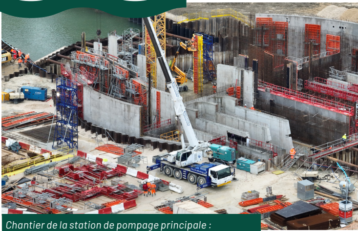
Chantier de la station de pompage principale : vue rapprochée des travaux de génie civil (voiles bétons)
