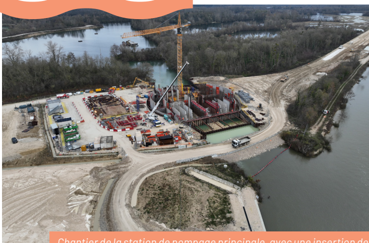
Chantier de la station de pompage principale, avec une insertion de l'ouvrage dans le chenal existant entre la Seine et l'étang de la Darse
