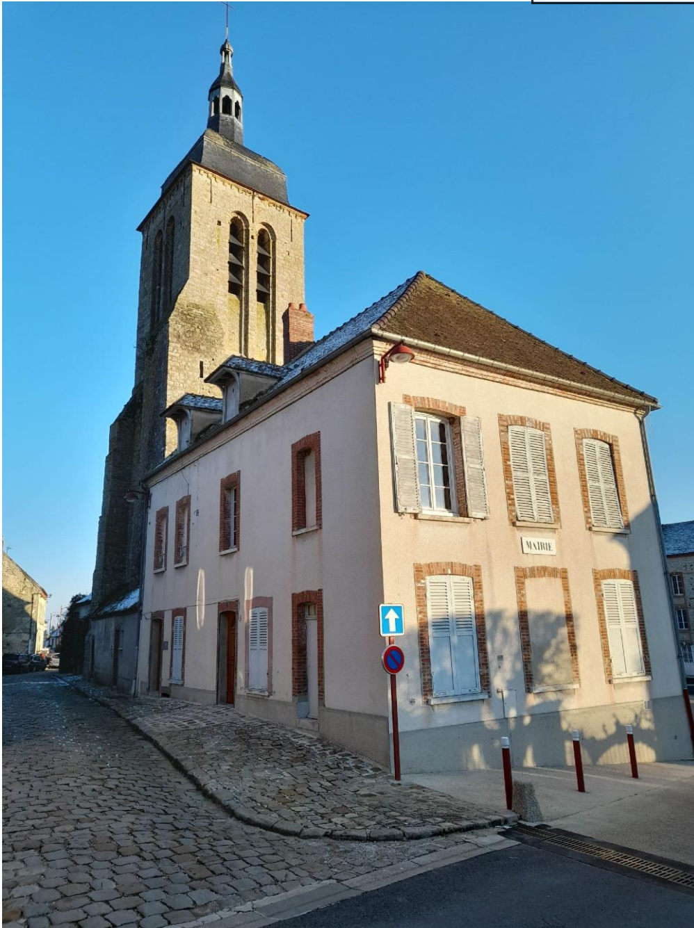
Photographie de la Mairie, accolée à l'Eglise.
