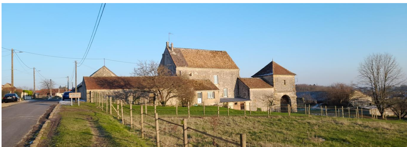
Photographie depuis la rue de la Fontaine Geoffroy, l'Eglise au fond à droite. Entrée de ville au Nord. ©UDAP77
