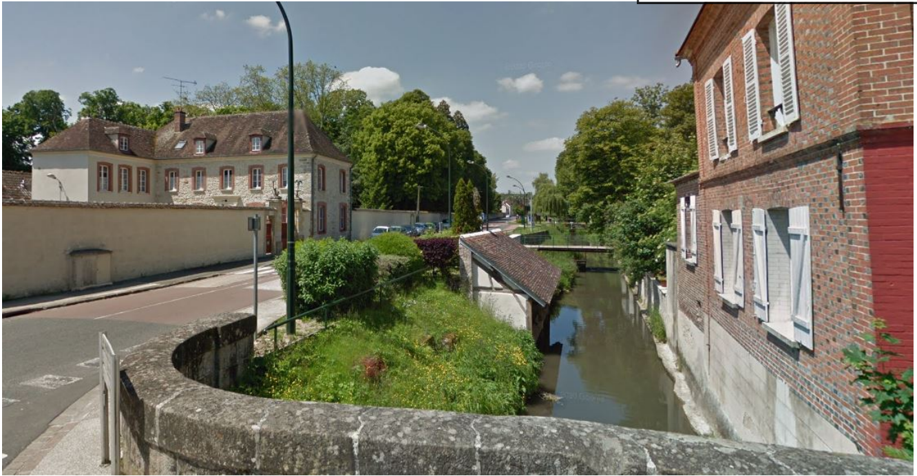
Photographie depuis le pont de la rue Marie Chaubart, un lavoir en contrebas ©Street view
