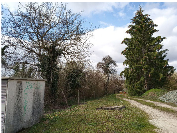
Chemin d'accès privé et transformateur électrique
