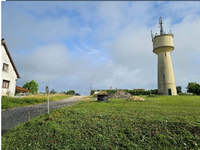
Accès depuis la rue de la Font Geoffroy
