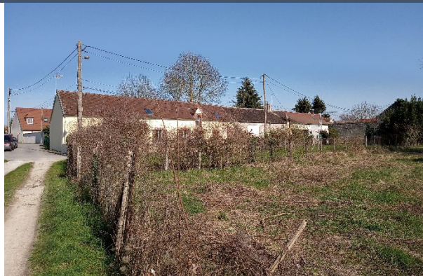
Vue depuis le chemin vers la rue du Joie
