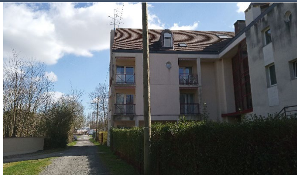
Vue sur la maison de retraite, vers l'est
