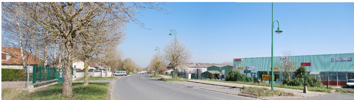
Vue vers le centre de Bray depuis le Nord de la D79 : stationnement et voie piéton/ vélo
