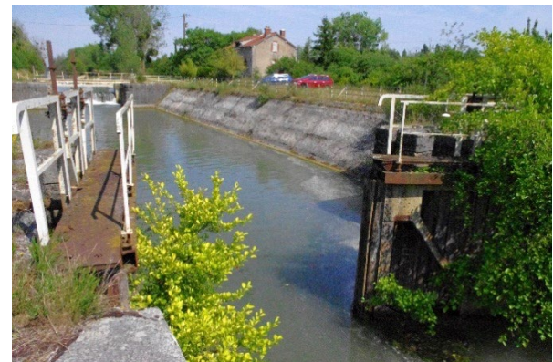
Figure 11 : ancienne écluse sur le canal de Bray-sur-Seine à La Tombe
