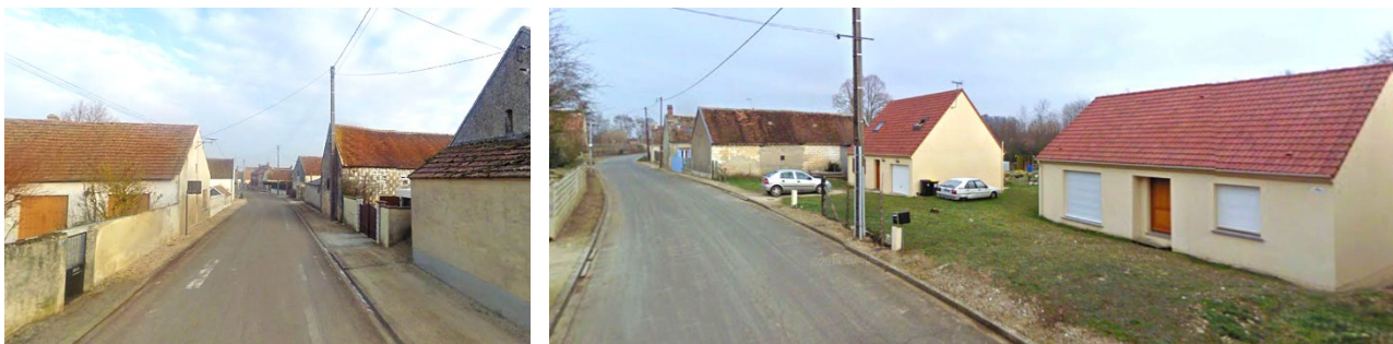
Figure 23 : rue des Forges à Villuis, la façade des constructions récentes est implantée parallèlement à la voie alors que la majorité du bâti ancien présente un pignon face à la voie, entraînant un fort impact dans le paysage urbain du bourg.
