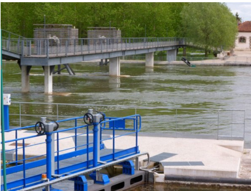
Figure 32 : la passerelle du barrage de Jaulnes, longue de 150 mètres
