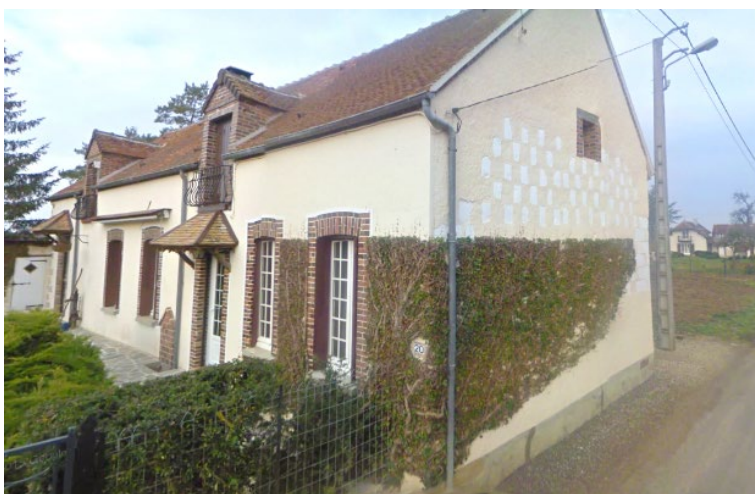
Figure 29 : pignon de maison à damier de craie à Villuis
