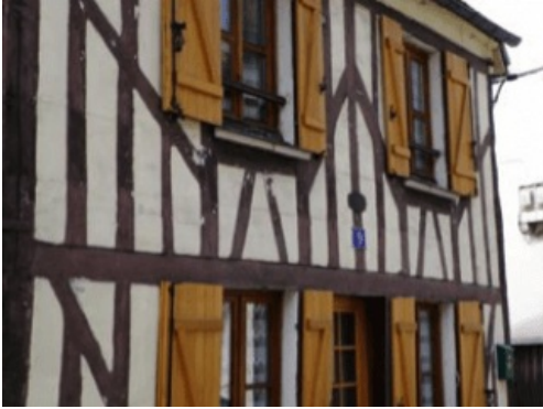
Dans les ruelles du vieux Bray
